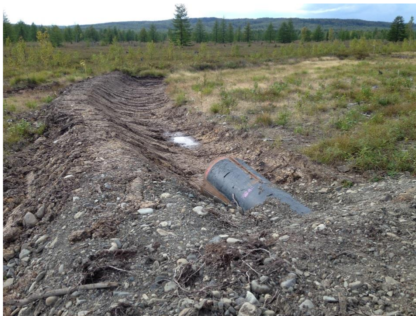
Фото 2. Новая водопропускная труба, низкое обвалование и неглубокая канава.
