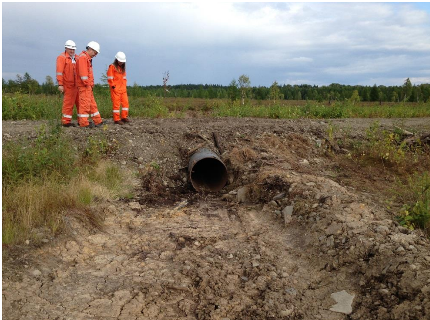
Фото 1. Новая водопропускная труба.
