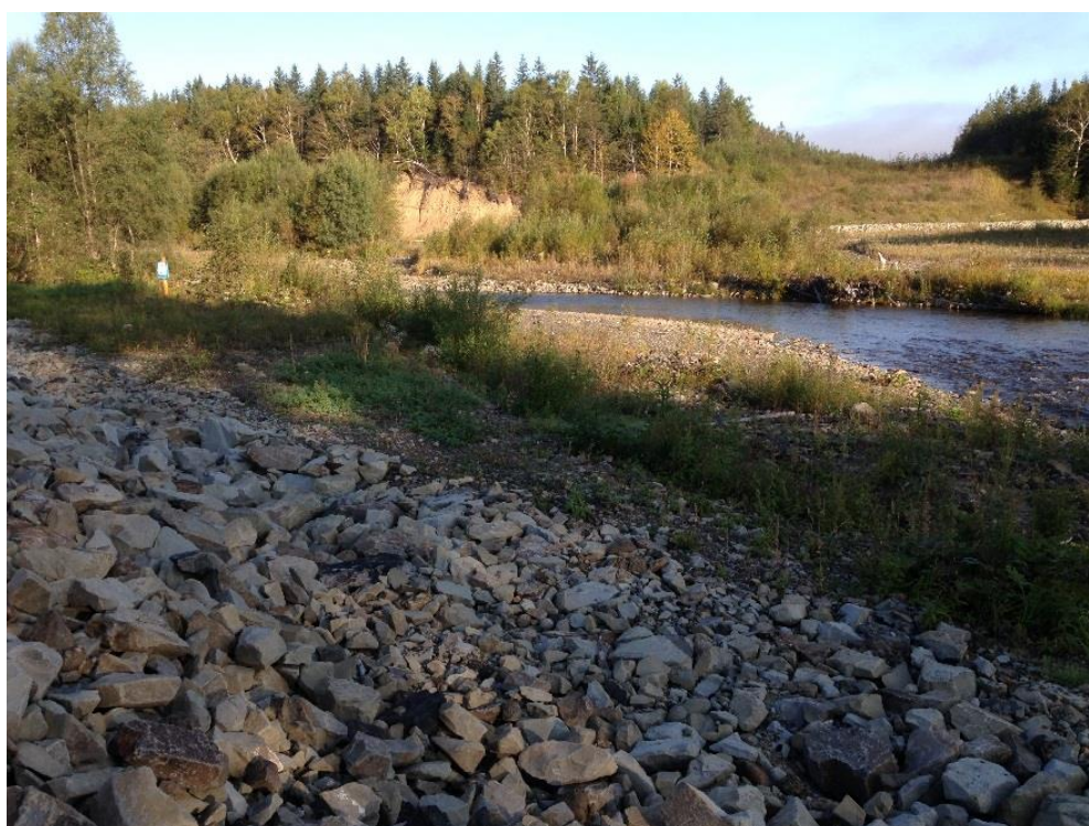
Фото 1. Переход через реку № 2 с каменной наброской по обе стороны реки.
