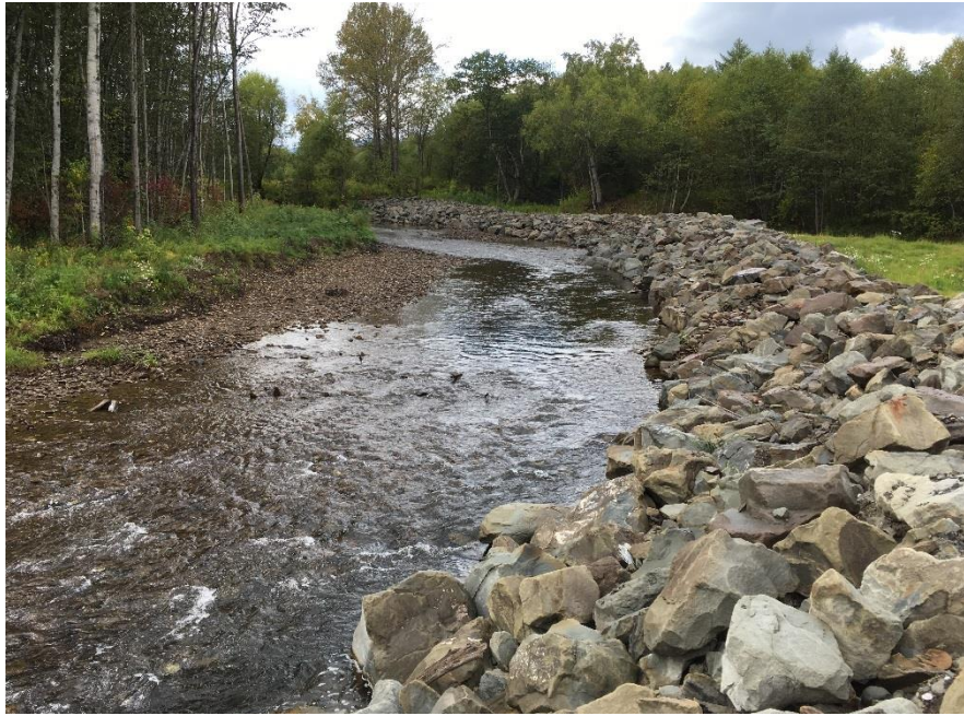
Фото 1. Каменная наброска для защиты от эрозии.
