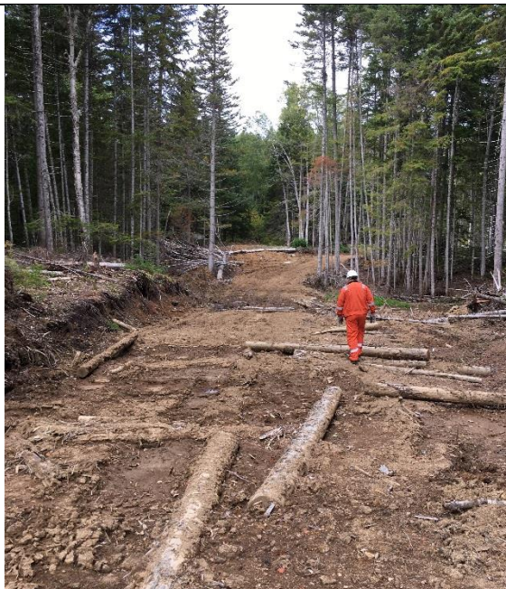
Фото 1. Недавно проложенная подъездная дорога к НКС-3.
