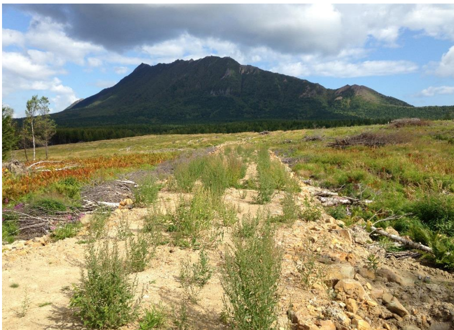
Фото 1. Часть расчищенной площадки для НКС-4.
